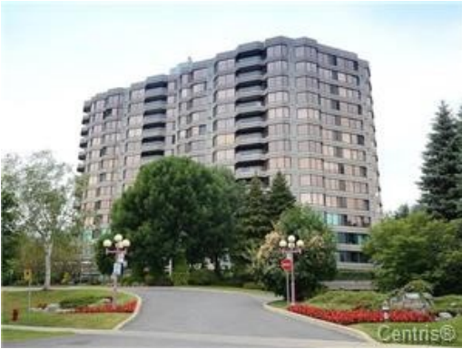
公寓楼整体外观
